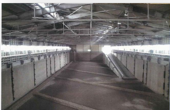
貯留施設内観
