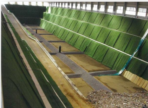
貯留施設内観
