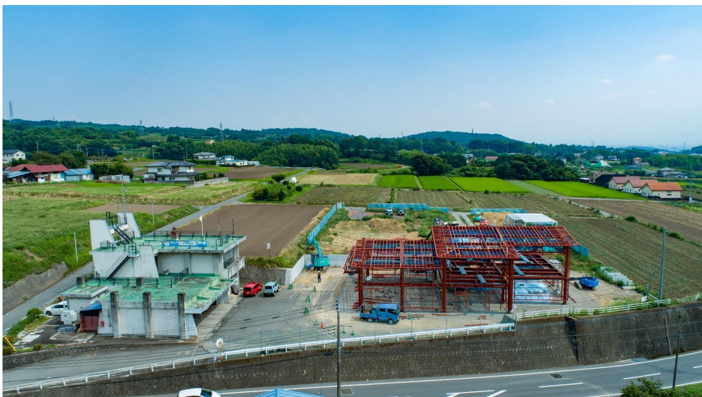
【庁舎の北側より撮影したもの】
