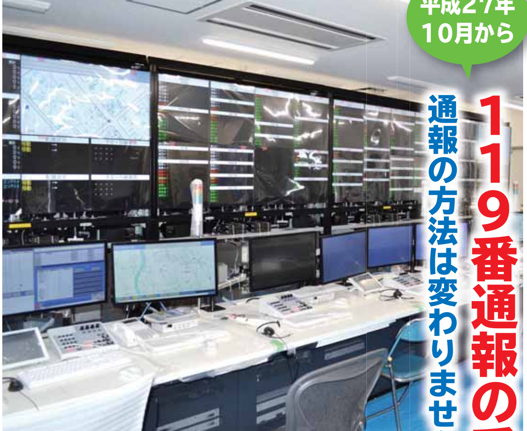
現在工事中の「たかさき消防共同指令センター」
