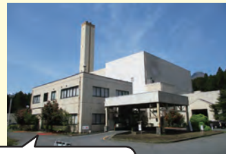
平成5年に供用開始した渋川広域圏清掃センター
