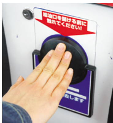
▲必ず静電気除去シートにタッチを
